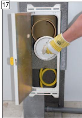
Design-Putztür öffnen und Revisionsverschluss abnehmen. (Bilddarstellung am Beispiel Revisionsverschluss „B“)
