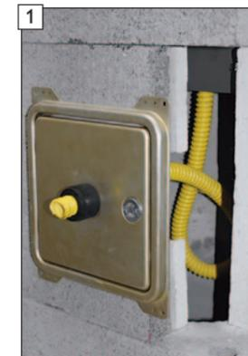
Lieferzustand ab Werk: Siphonschlauch und Adapter für HT-Rohrverbindung DN40 sind in der BlowerDoor Kondensatblendentür eingesteckt oder ...
