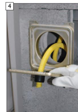
BlowerDoor Kondensatblendentürblatt abnehmen und Adapter für HT-Rohrverbindung DN40 mit Siphonschlauch herausziehen.
